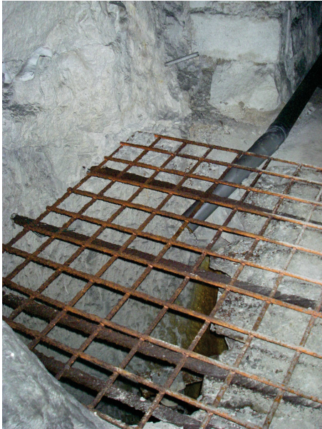
photo 2: Drainage des eaux d'infiltrations par les puits d'aération (carrière Lemée-Lévy)
