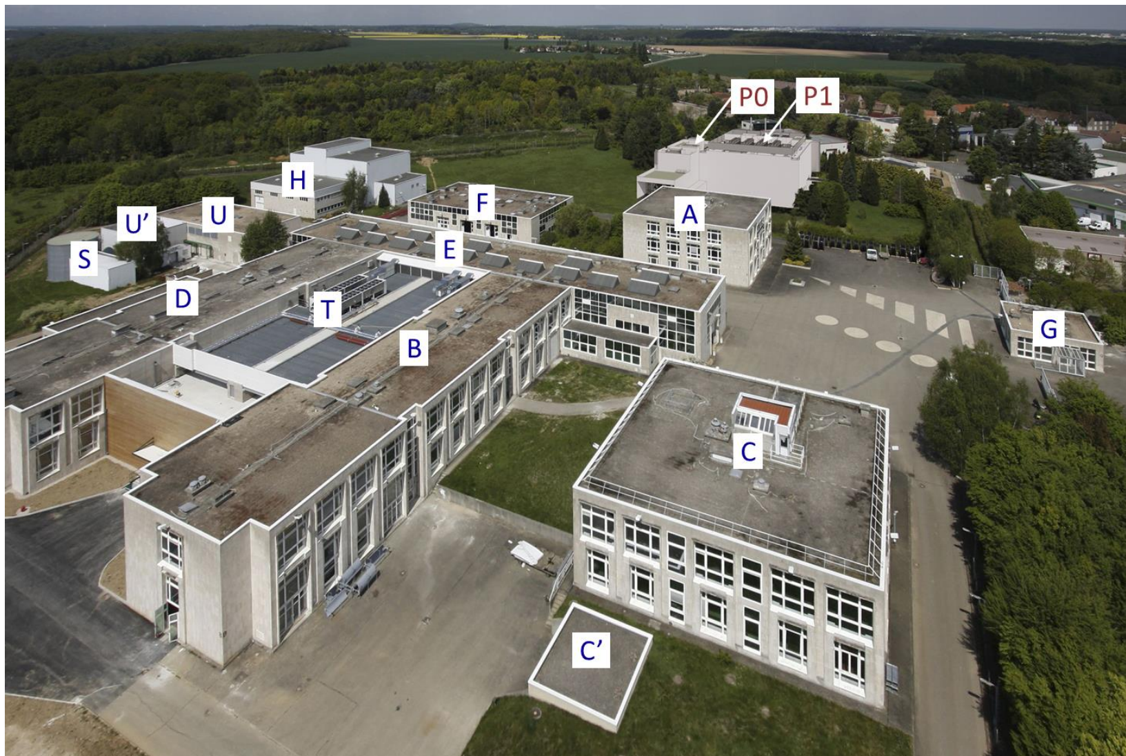
Figure 6 : Vue aérienne du site actuel
