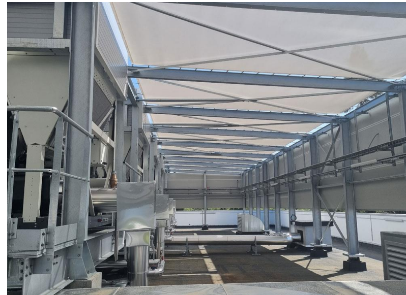
Figure 6 Vue du toit du bâtiment P1 en cours d'achèvement, avec les toiles tendues qui protègent de la chaleur.
