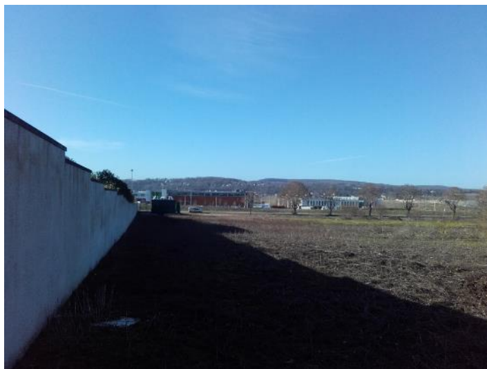
Figure 22 - Photo 16 - Mur d'enceinte de la déchetterie Azalys (Source: GPS&O)
