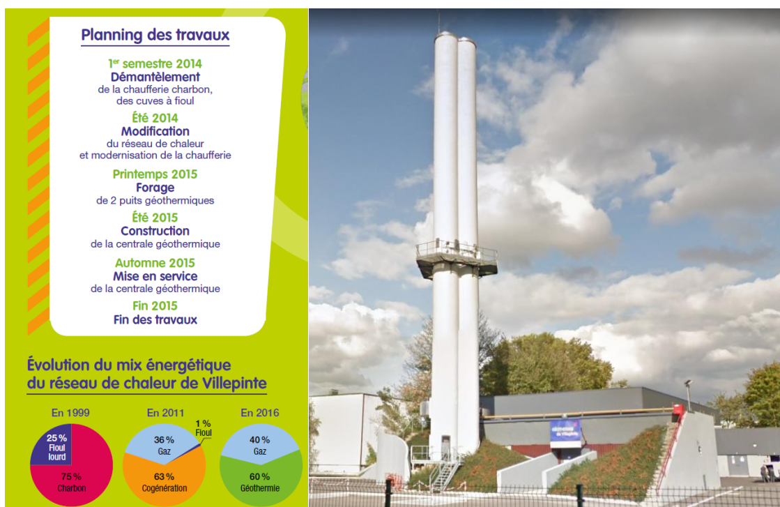
Figure 26 – Centrale géothermique de Villepinte ayant permis le démantèlement d'une chaufferie charbon
