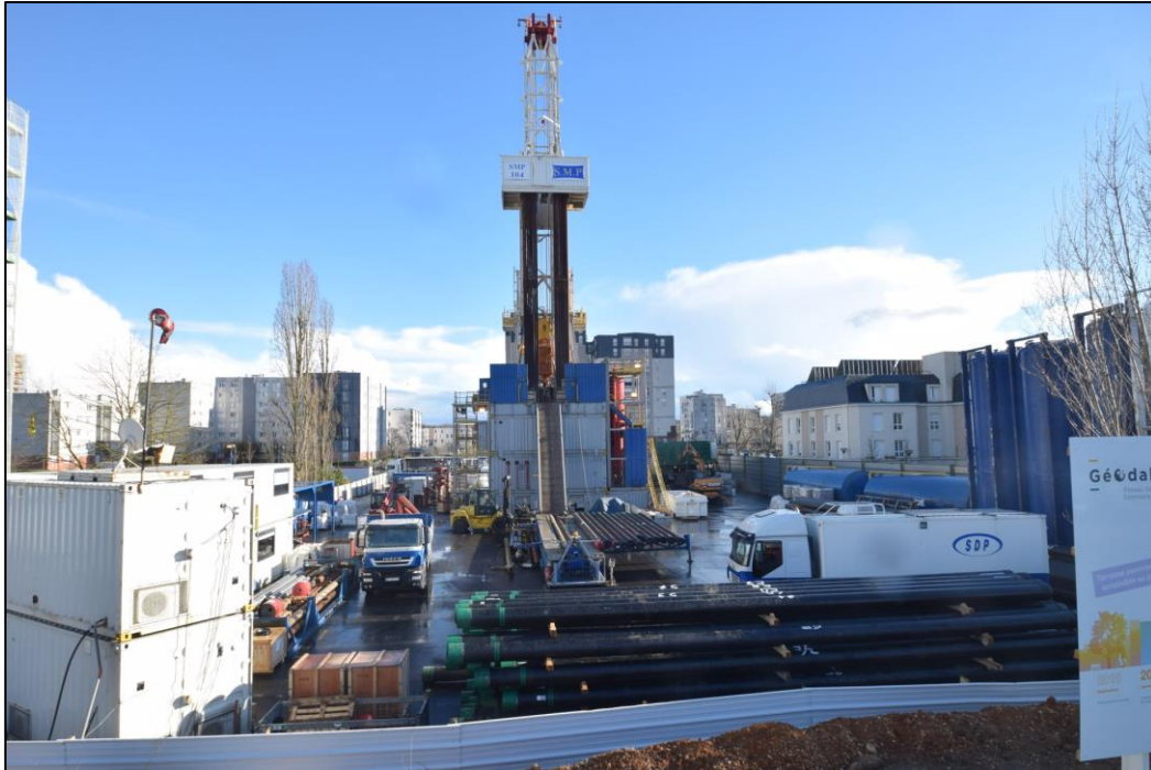
Figure 22 – Photo d'un site de forage (Dammarie-les-Lys, 2017)
