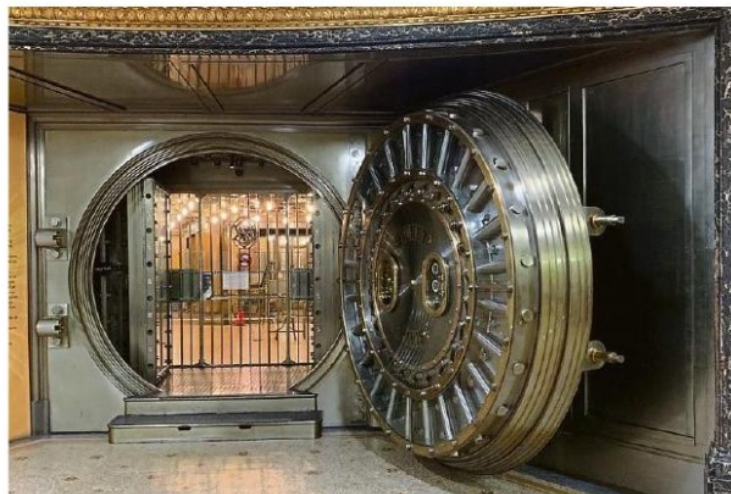
Derrière cette porte circulaire de 16 tonnes avec un blindage de 40 centimètres d'épaisseur se trouve plus de 8.000 coffres, sur quatre niveaux. Photo Romain Gueugneau
