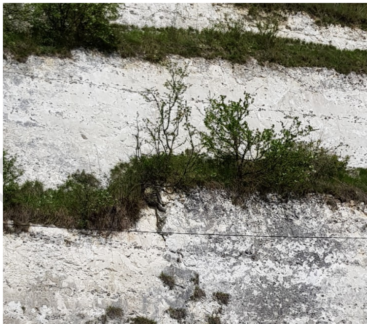
Illustration 27 : végétation sur le front pouvant le dégrader – front rocheux FR4 le long de la RD147 (source : Cerema).
