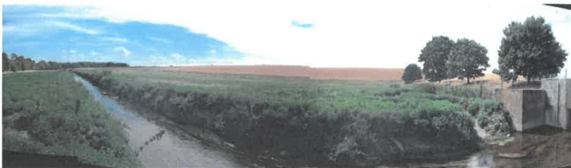
FIGURE 2 : PHOTOGRAPHIE DE LA CUVETTE, EN AMONT DE L'OUVRAGE DE RETENUE
