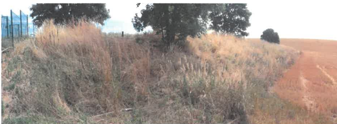
FIGURE 3 : PHOTOGRAPHIE DU BARRAGE EN REMBLAI (VUE DU TALUS AVAL RIVE GAUCHE)
