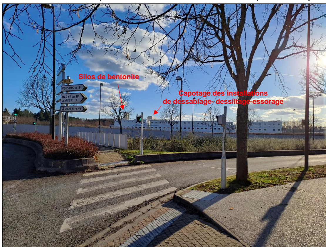
Photo 2 : Vue du site depuis la sortie ouest de la place de Villaroy
