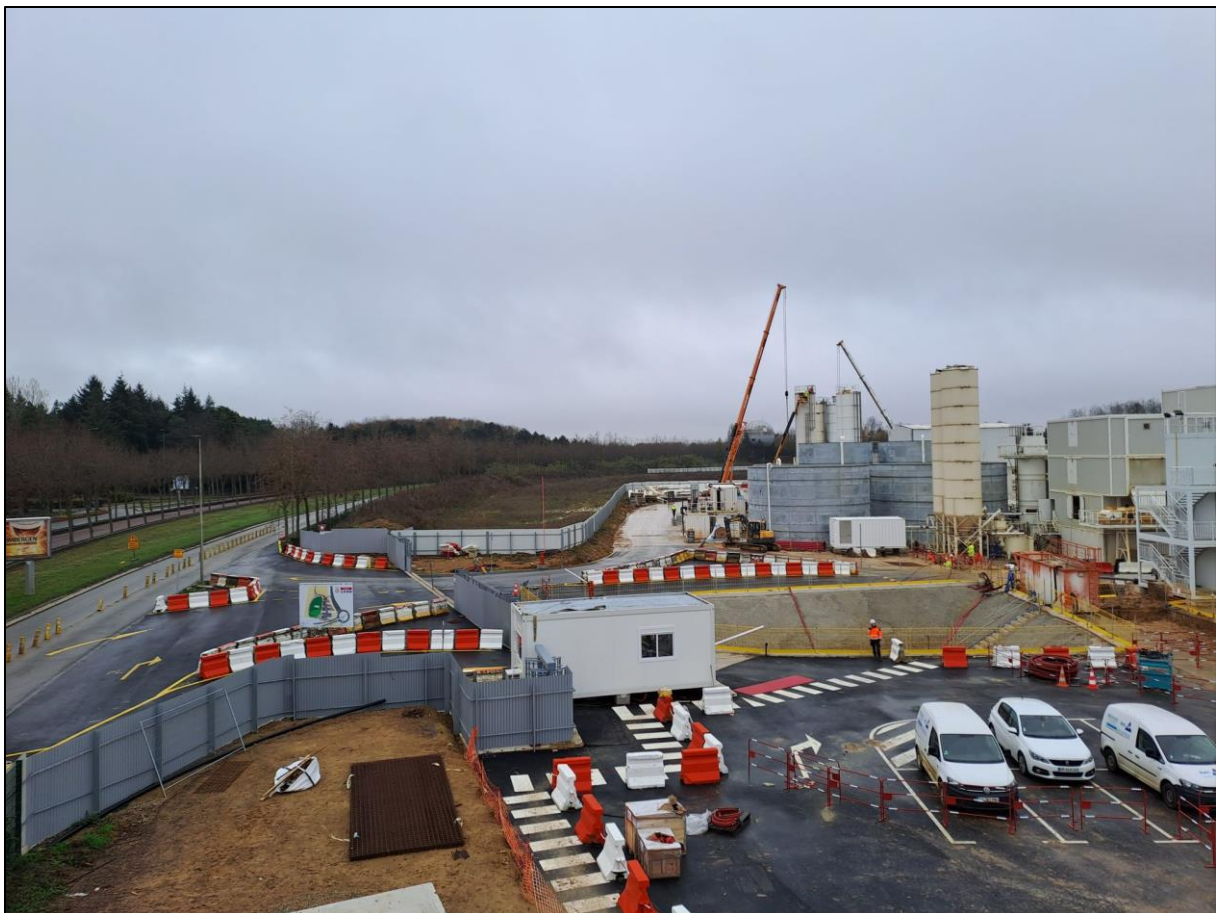
Figure 4 : Vue de l'accès principal au site
