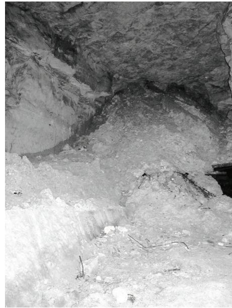
photo 5: Fontis non ceinturé en bordure du chemin des Soudannes
