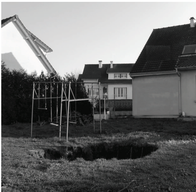
photo 7: Fontis venue à jour dans une zone pavillonnaire
