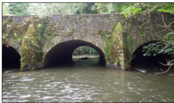
Pont de Vaugien
