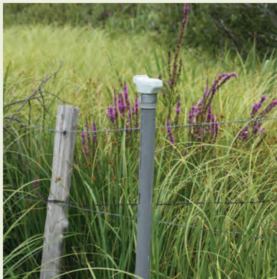
Piézomètre équipé d'une sonde de mesure automatique
