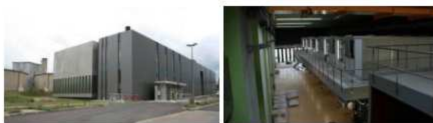
Figure 11: Unité d'épaississement des boues
