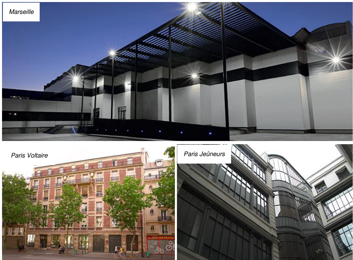
Figure 3 : Illustrations des datacenters TELEHOUSE Marseille, Paris Voltaire et Paris Jeûneurs
