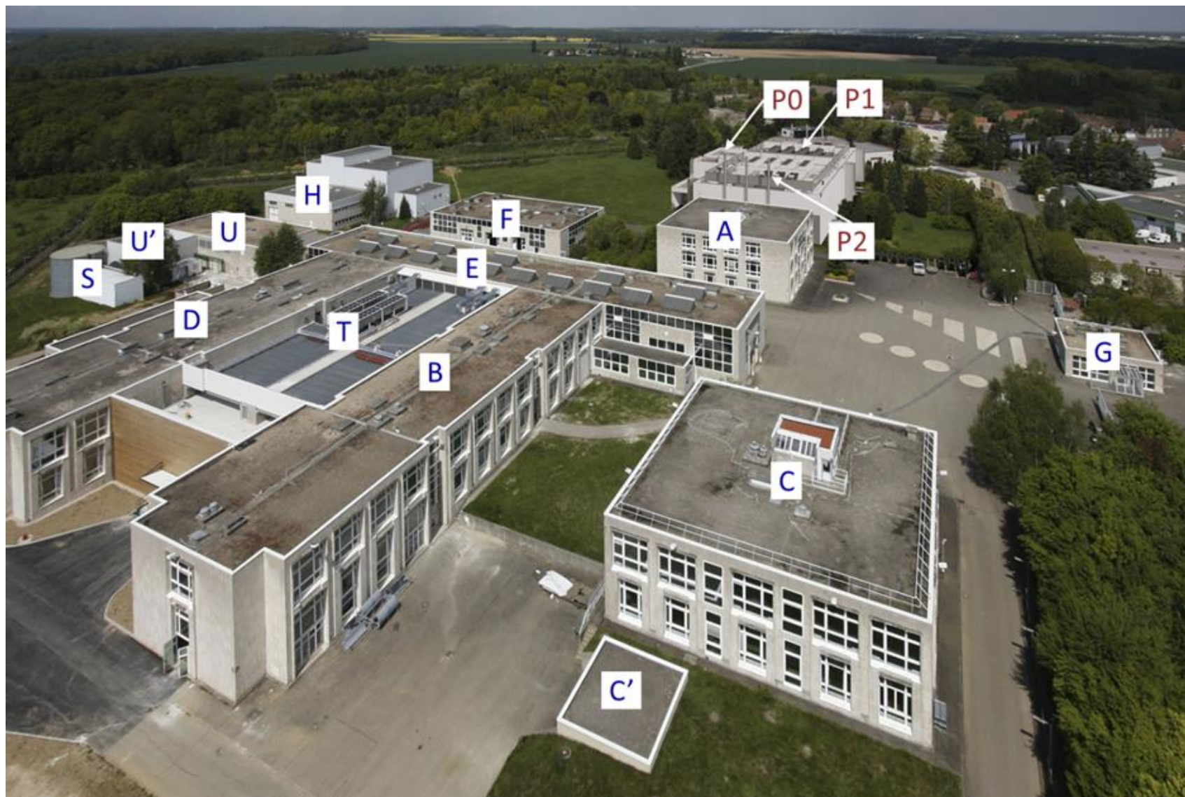
Figure 3 : Vue aérienne du site dans sa configuration projetée avec P2
