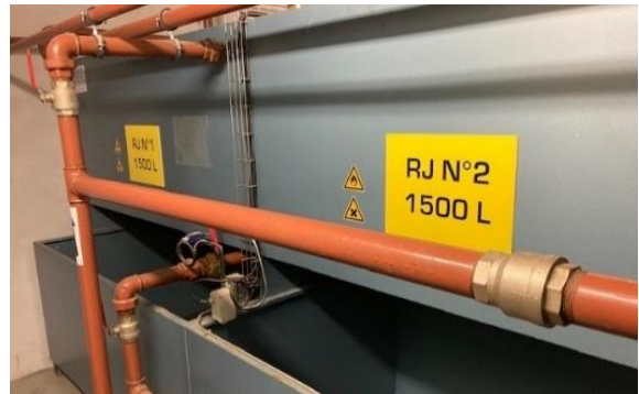
Figure 9 : Nourrices fioul présentes dans un local spécifique du bâtiment U
