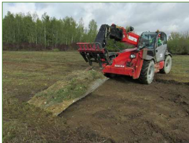
Mise en place de la plaque de végétation avec le télescopique (à gauche) ; comme elle ne glisse pas spontanément, elle est poussée délicatement par la pelle mécanique.
