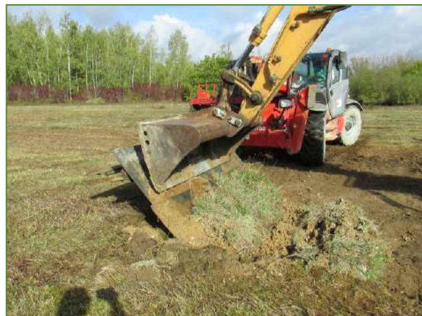
Mise en place de la plaque de végétation avec le télescopique (à gauche) ; comme elle ne glisse pas spontanément, elle est poussée délicatement par la pelle mécanique.
