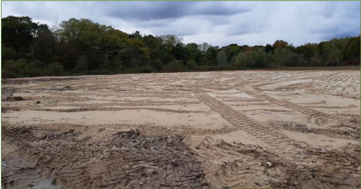
Résultat final du déplacement en vrac des sols sur la zone d'accueil après un premier nivellement du sol.
