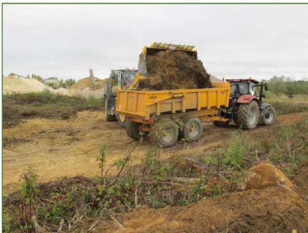
Chargement et transport par bennes des sols décapés.
