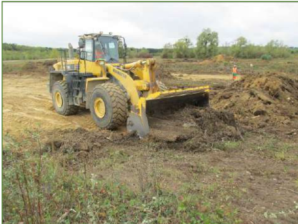
Décapage des pelouses sur 15 à 20 cm d'épaisseur et stockage en tas des terres décapées.
