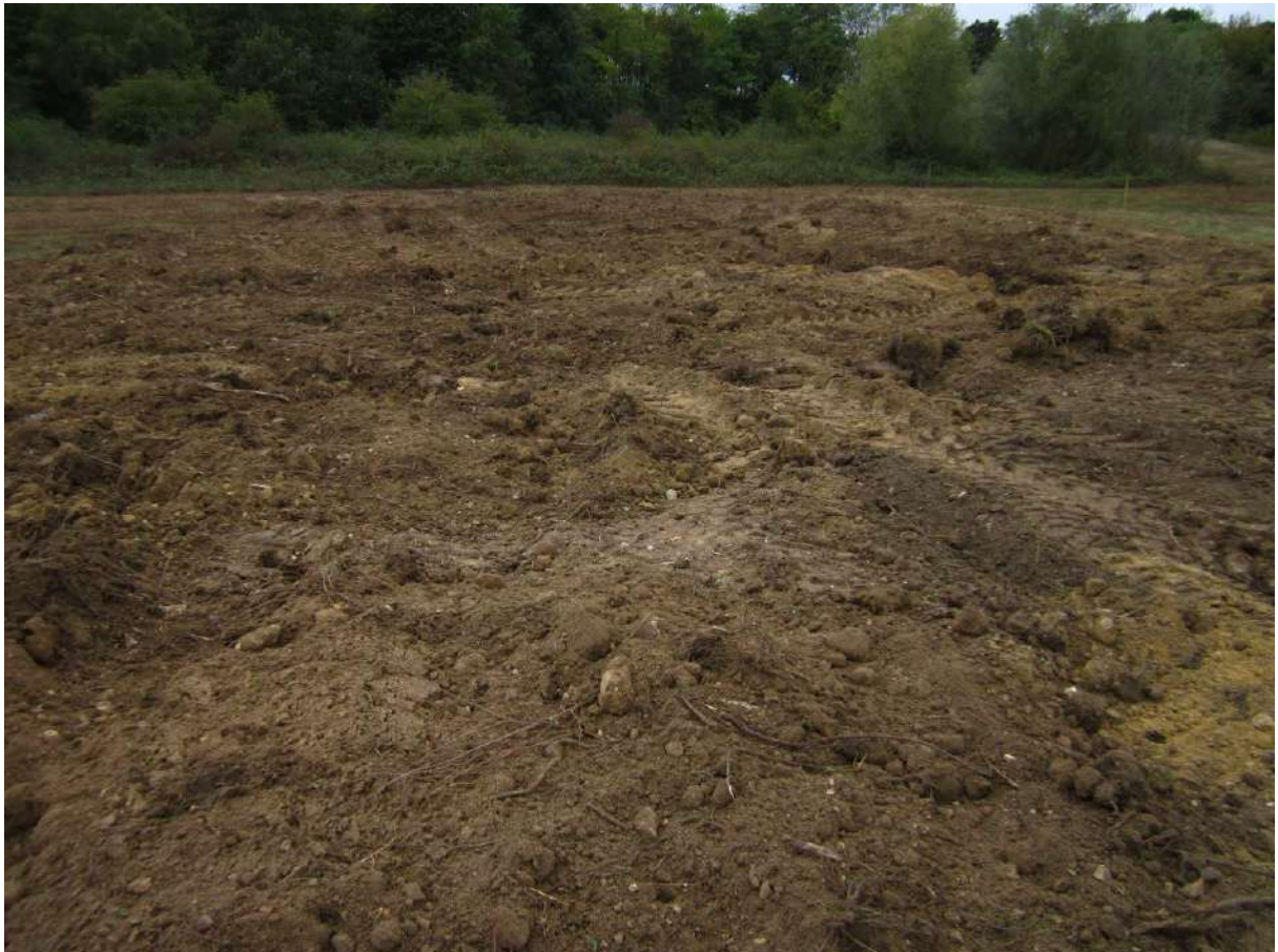
Résultat du régilage ; un nivellement complémentaire est nécessaire pour avoir une pelouse régulière facile à gérer par fauche.
