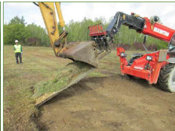
Mise en place de la plaque de végétation avec le télescopique (à gauche) ; comme elle ne glisse pas spontanément, elle est poussée délicatement par la pelle mécanique.
