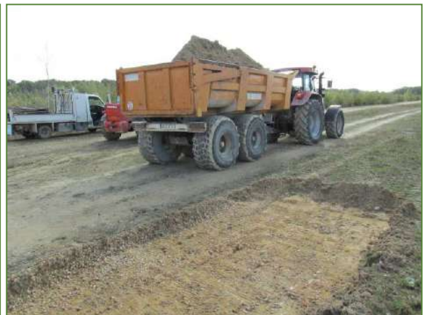
Chargement et transport par bennes des sols décapés.
