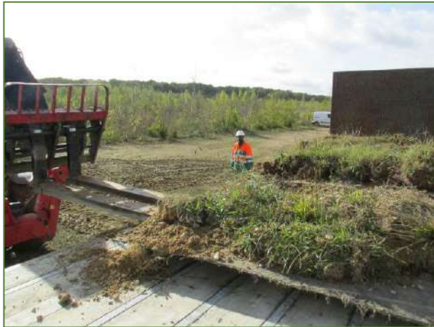
Reprise des plaques et transport pour mise en place sur la zone d'accueil
