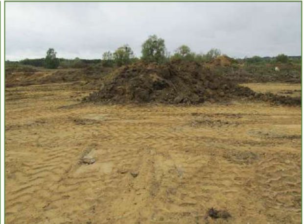
Décapage des pelouses sur 15 à 20 cm d'épaisseur et stockage en tas des terres décapées.
