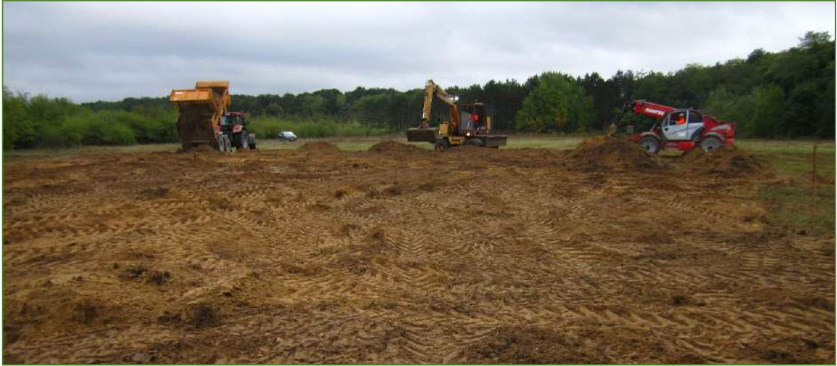
Déchargement des terres décapées sur la zone d'accueil (à gauche) et son régilage.
