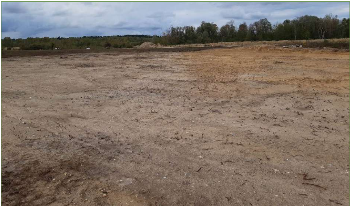
La zone du bassin de compensation hydraulique après décapage des pelouses.
