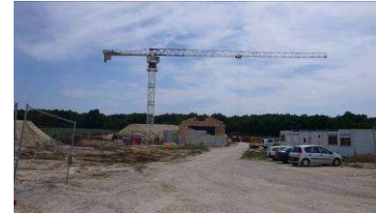
Construction de l'usine de pompage et de traitement des eaux de Saint-Martin-la-Garenne, © B.Lelaure
